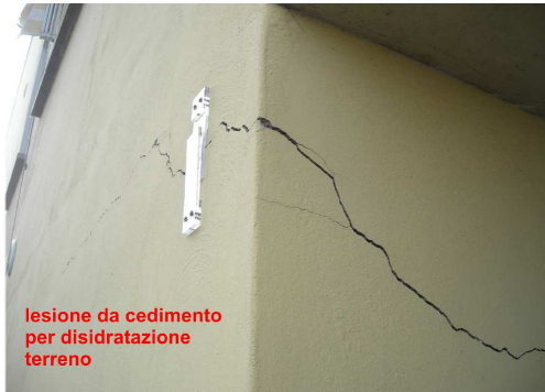
ESEMPI QUALITATIVI DI LESIONI DA CEDIMENTO PER DISIDRATAZIONE DEL TERRENO E PER LESIONI DA RIGONFIAMENTO PER REIDRATAZIONE
