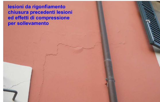
ESEMPI QUALITATIVI DI LESIONI DA CEDIMENTO PER DISIDRATAZIONE DEL TERRENO E PER LESIONI DA RIGONFIAMENTO PER REIDRATAZIONE
